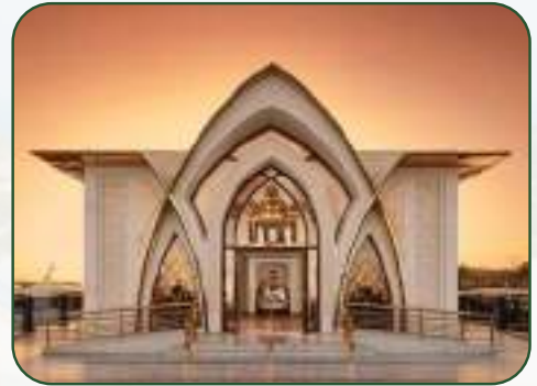
AL SHYOUKH PORT TERMINAL
